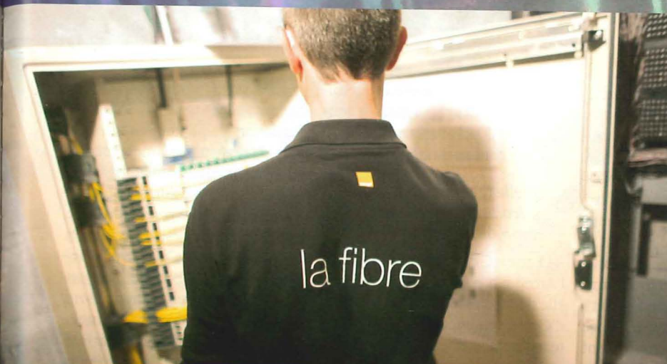
La fibre optique se substitue peu à peu au fil de cuivre pour acheminer la télévision, internet et le téléphone. Les câbles contenant les fibres sont enterrés dans la rue (en bas à gauche) puis conduits jusqu'à un coffret mural dans l'immeuble (ci-contre).
